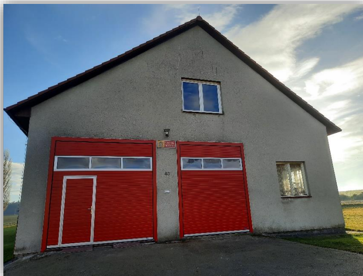
Hasičská zbrojnice Hrazánky - nová vrata
